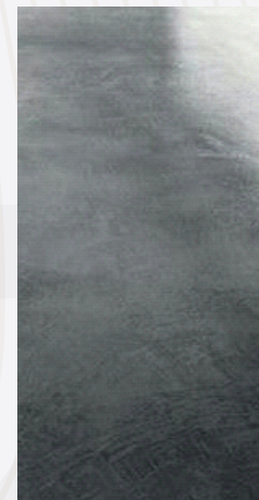
Concreto Pulido Sótano y Cubiertas De Rooftop.
